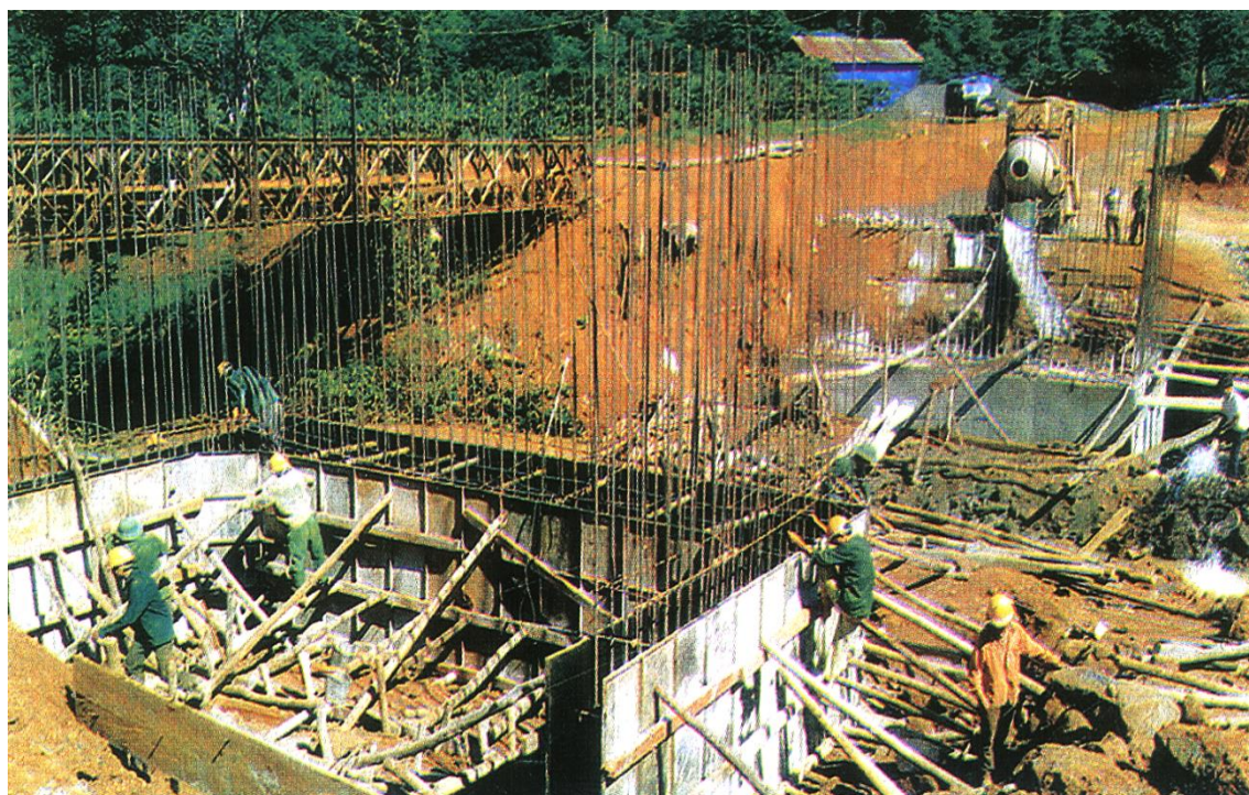
Thi công cầu Đắc Phan (công trình Trường Sơn Đông) của Công ty 711
